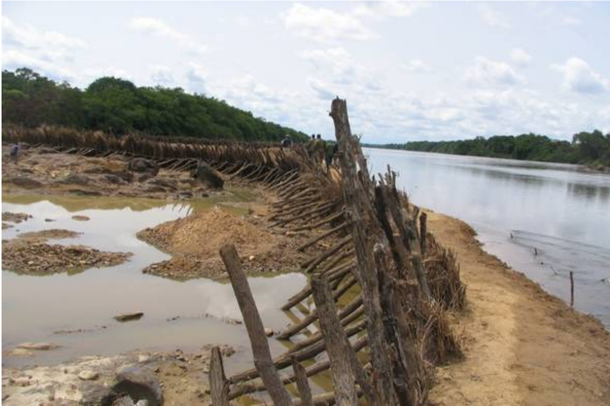
Digue d'exploitation artisanale construite par les ouvriers miniers d'un chantier diamantifère en RCA.
