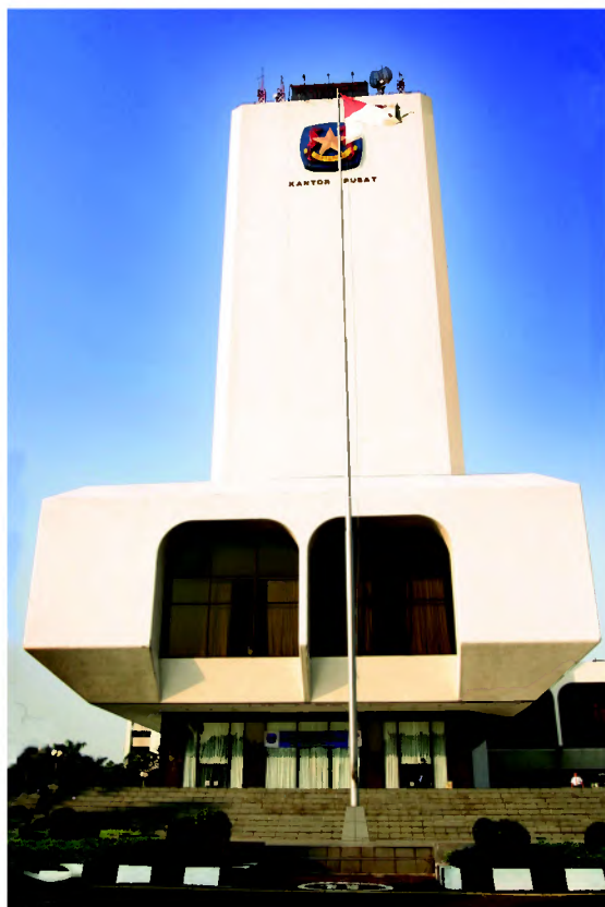
Gedung Pertamina Tampak Depan, PT Pertamina
