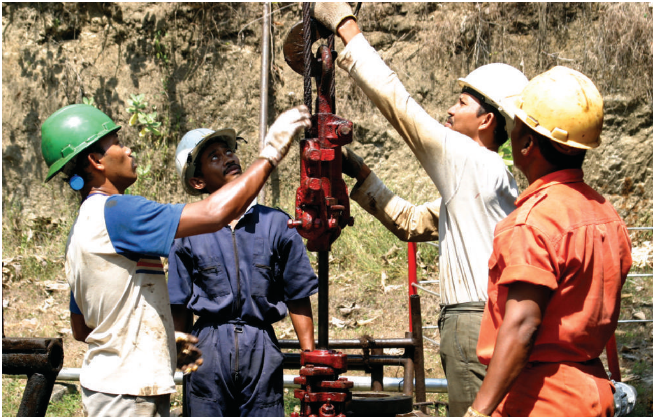
Perbaikan Sumur Minyak - PT Pertamina EP
